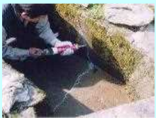
水路のひび割れ補修
