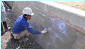
老朽化した水路壁のコーティング
