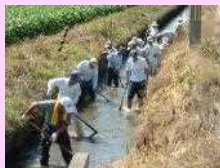
水路の泥上げ
