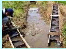
水田魚道の設置
