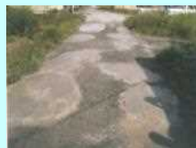
農道の窪みの補修
